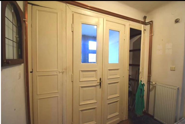
Drzwi wewnętrzne do przedsiionka oraz wbudowana szafa wnękowa na pierwszej kondygnacji.
