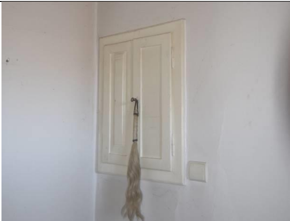
Okienko podawcze między kuchnią, a salonem na pierwszej kondygnacji.
