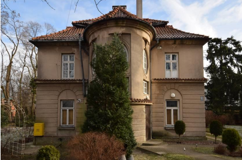
Elewacja zachodnia (od strony ulicy Topolowej).
